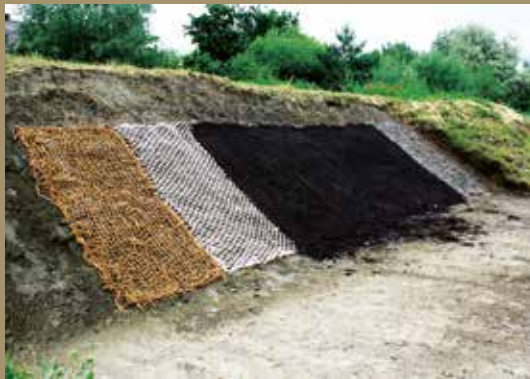
LITE-NET comparé avec nattes de coco conventionnelles - Études BOKU
