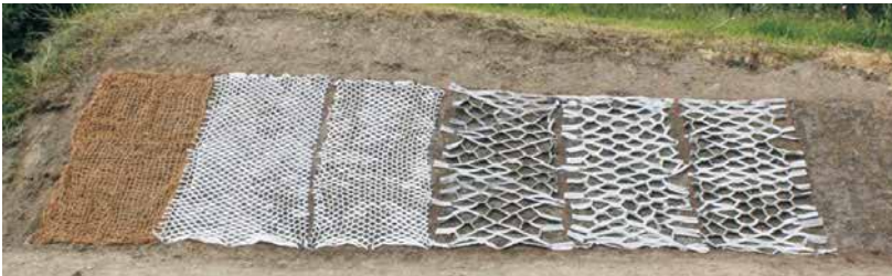
Versuchsböschung nach der Hydrosaat
